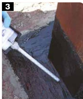
3 Impermeabilización mediante la aplicación de la masilla elastomérica
