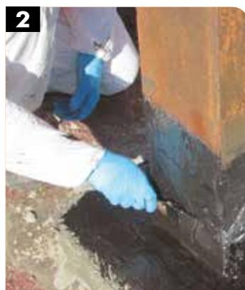
2 Aplicación de resina epoxica para la protección contra la corrosión
